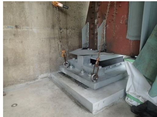
写真-8 免震支承設置状況
