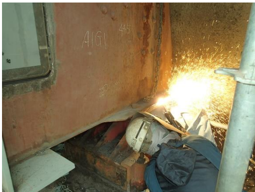
写真-7 既設支承撤去状況
