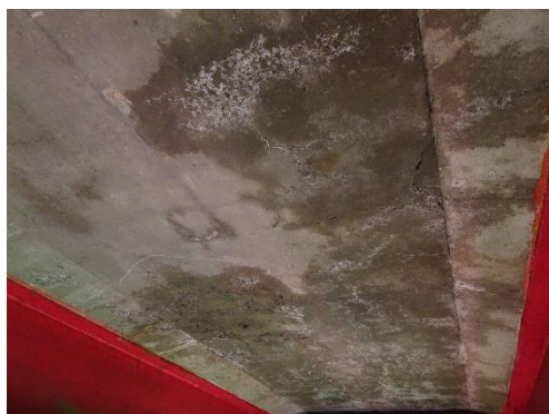
写真-4 床版下面状況①
