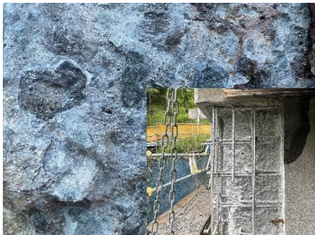
写真-12 コンクリートはつり状況
