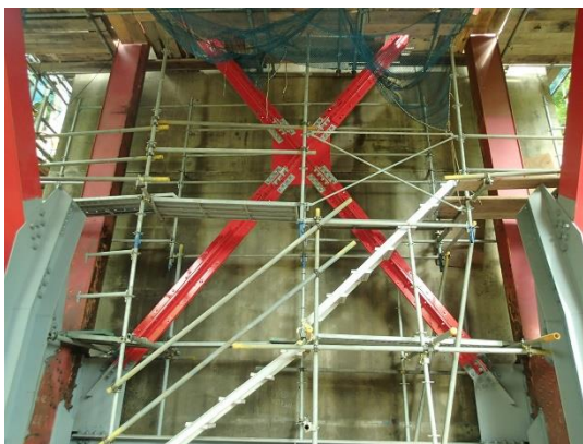
写真-10 座屈拘束ブレース材設置状況
