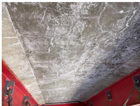
写真-5 床版下面状況②
