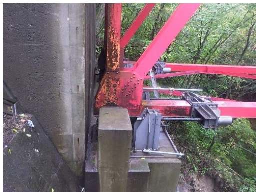
写真-3 端部対傾構状況
