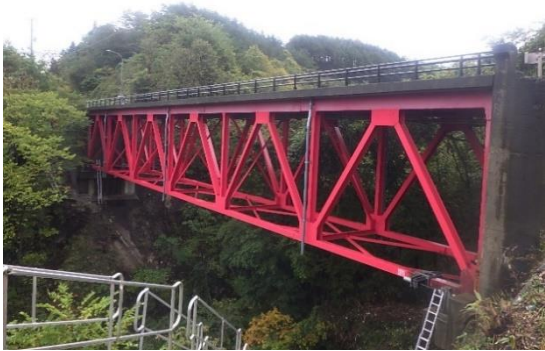
写真-1 橋梁状況
