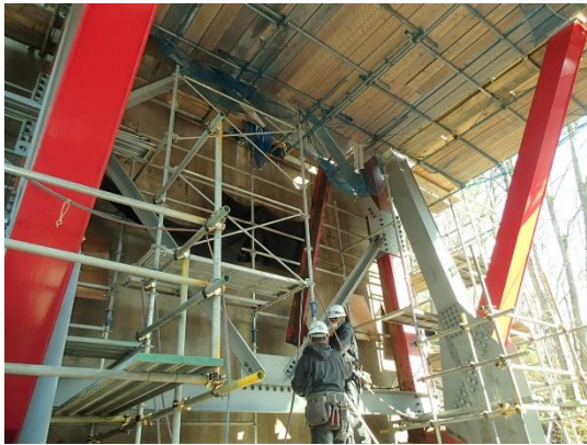
写真-9 間隔保持材設置状況
