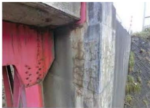
写真-6 橋台側面状況
