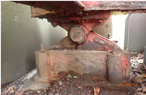
写真-2 支承状況
