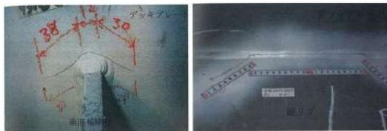
図 1.12 亀裂の写真（左：補剛材溶接部の亀裂、右：デッキプレート溶接部の亀裂）
