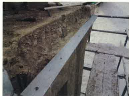
写真-14 補強部材
