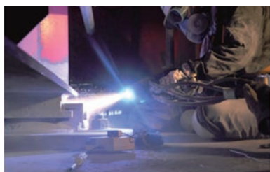
図6 支承への金属溶射
