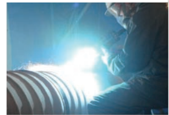
図2 金属溶射の施工状況
