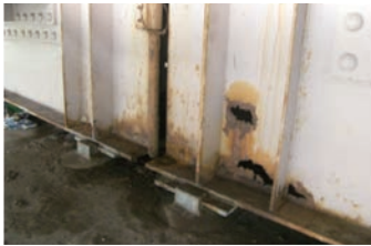
図1 鋼橋の腐食状況
