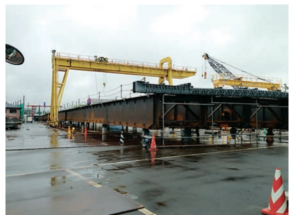
長さ約150mまで延長されたクレーンヤード
