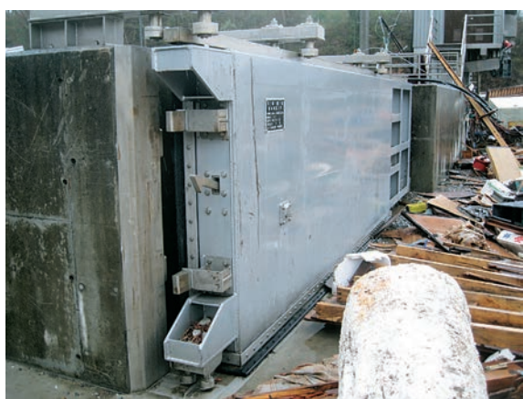
瓦礫を取り除き調査が進められる
