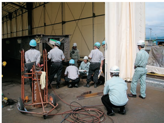
JR東日本様による大浜川橋梁の検査
