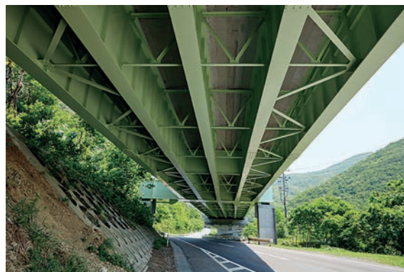
国交省 三陸国道事務所より安全優秀工事表彰を受けた豊石跨道橋
