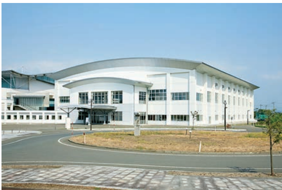
増築された花巻市総合体育館(伊藤組様、滝田工務店様とJVで施工)
