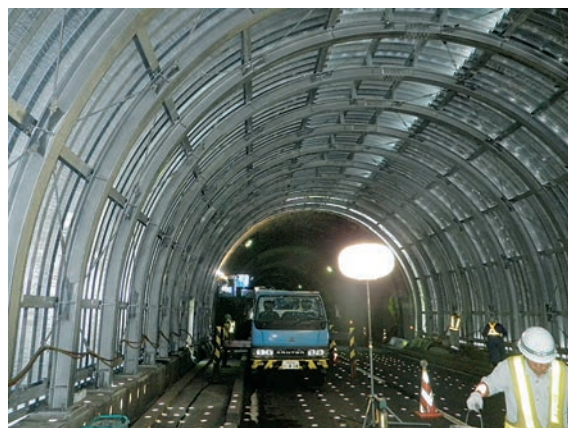
岩手県より優秀工事表彰を受けた向山スノーシェルターの施工状況
