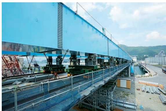
送り出し架設中の川口橋(横河ブリッジ様とJVで施工)
