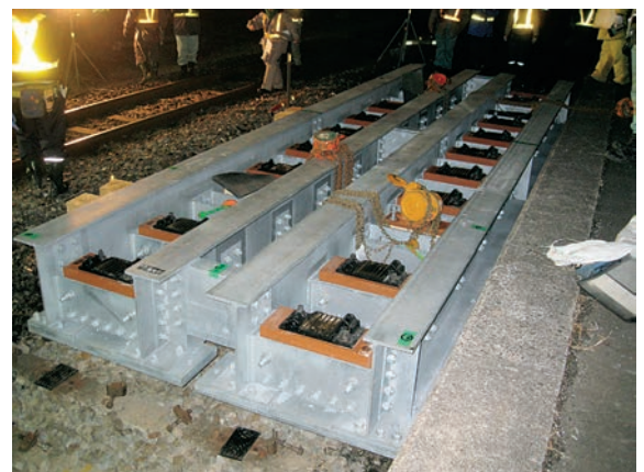
列車荷重が載荷される鉄道橋(塩釜街道架道橋)
