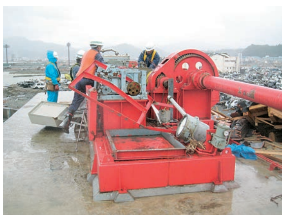
被災した水門の調査
