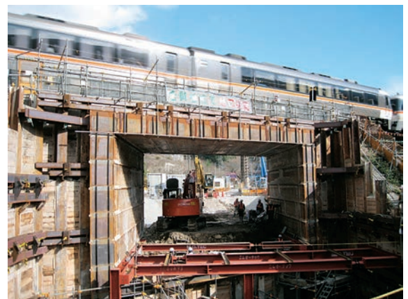
当社からジェイテック様向けに出荷した JR東海 中呂Elementの施工現場
