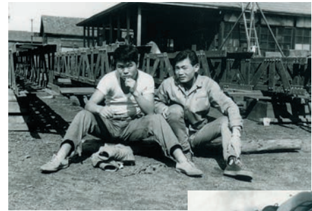
昭和30年代の工場の様子
