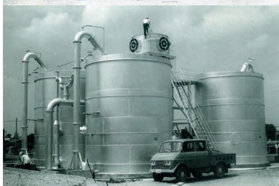
埼玉県深谷市逆栓ろ過タンク
