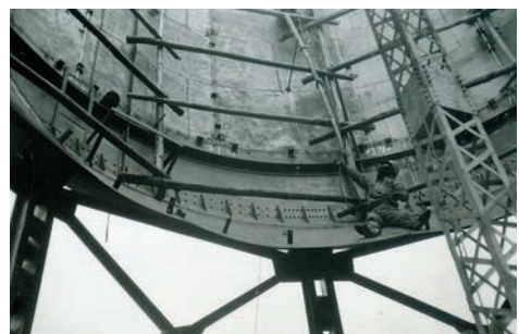
宮城県釜房ダムセメントサイロ
