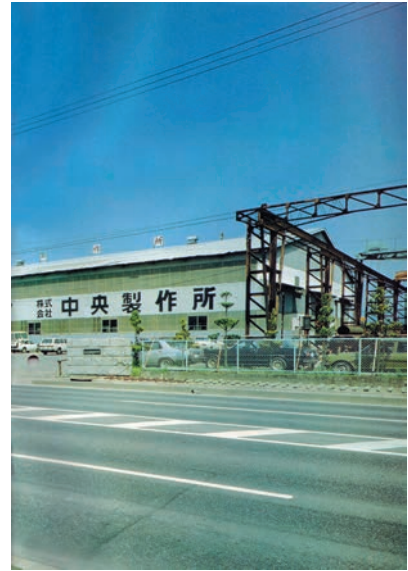
増設中の工場
