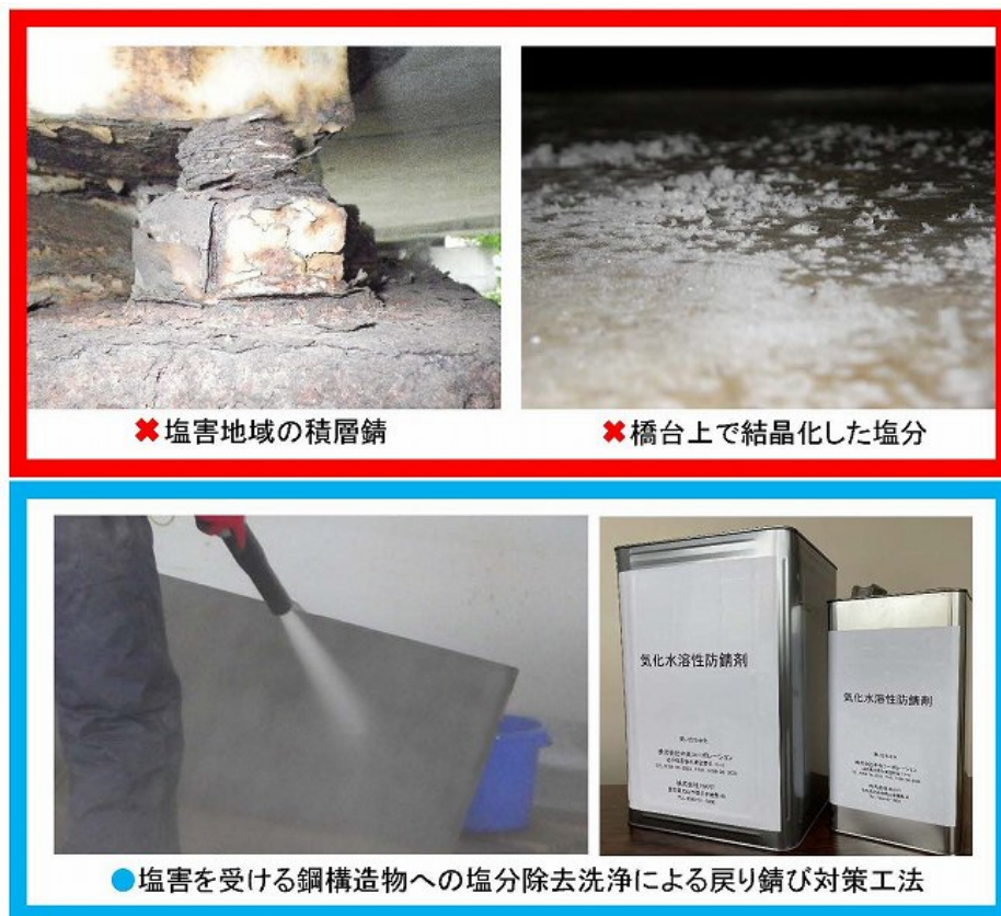
塩害の現状と気化水溶性防錆剤
