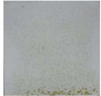
水洗浄(戻り錆び発生)
