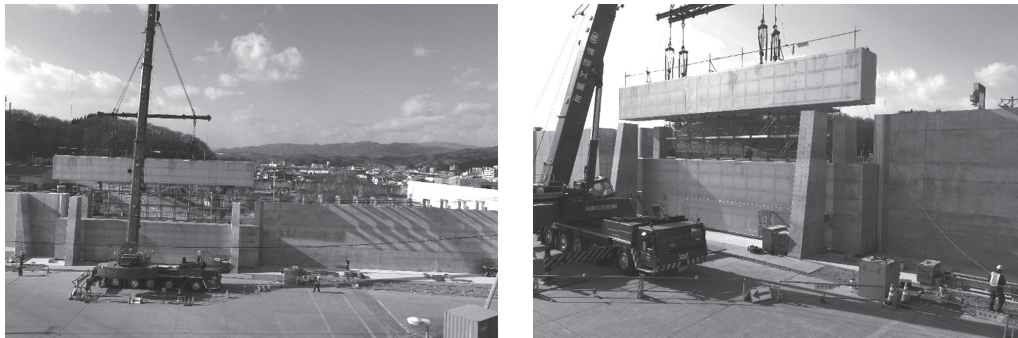
写真2 1号陸閘施工状況
