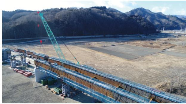
写真-5 あらかじめ主桁に吊り足場を設置
