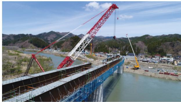
写真-6 大ブロック架設(650tクレーン)
