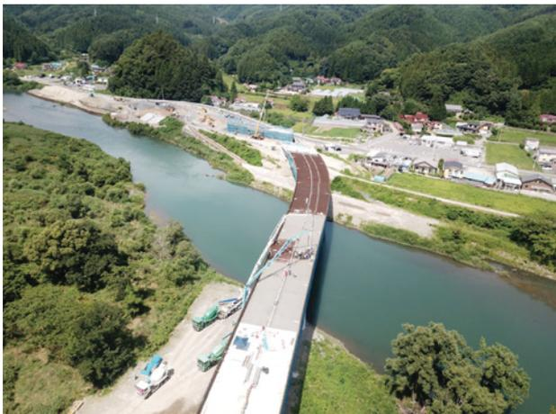
写真-4 床版コンクリート打設状況
