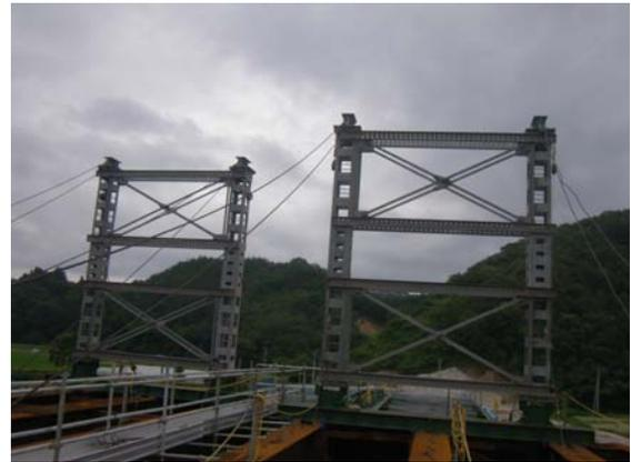
写真-10(ビロン柱設置状況)
