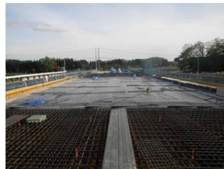
写真-3 養生状況
