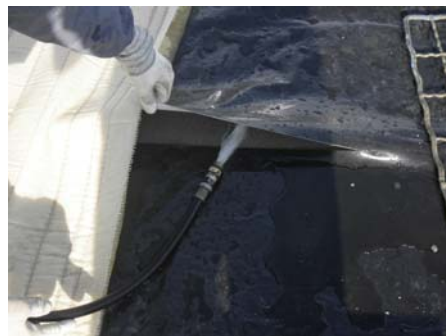
写真-2 給水状況
