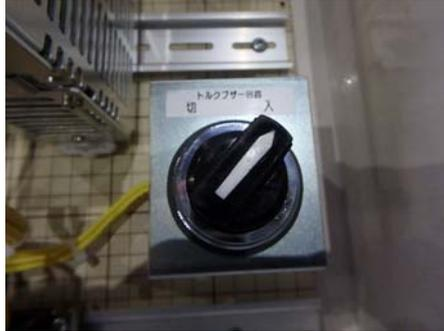
写真-5 トルクブザー回路
