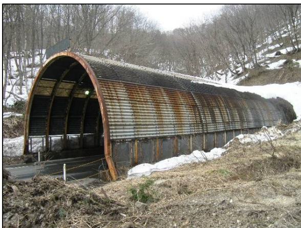
写真—1: 更新前 向山2号スノーシェルター外観
