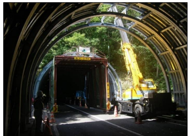
写真—2：向山1号スノーシェルター架設状況
