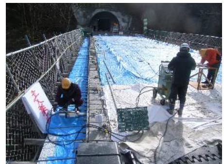
写真-1 PC鋼材横締め緊張状況
