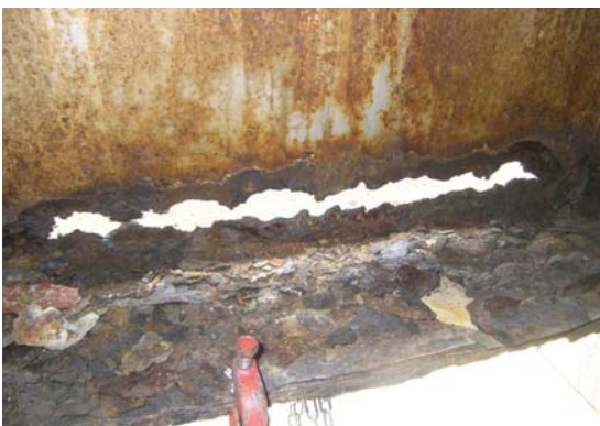
写真-1 主桁下フランジ腐食損傷
