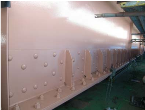
写真-6 鋼桁補強状況
