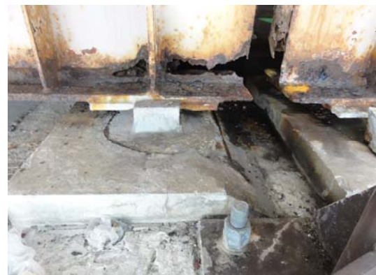
写真-2 桁端部腐食損傷
