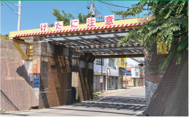
東北本線 花巻 Bv／ 190 [元請／ユニオン建設(株)] 東日本旅客鉄道(株) 岩手県花巻市 単線開床式単純上路プレートガーダー L 7.0m 鉄道桁
