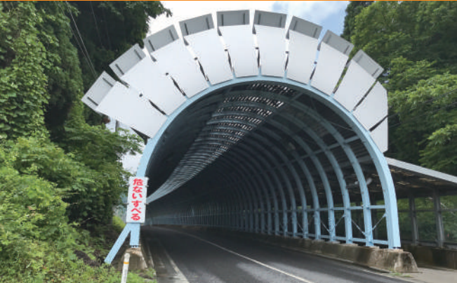
川舟スノーシェルター／ 221 岩手県県南広域振興局 岩手県西和賀町 2 ヒンジアーチ式鋼製スノーシェルター 施設延長 60m 幅員 7.5m
