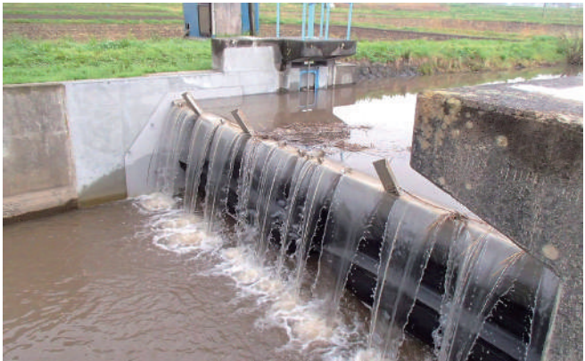
針前堰ゲート／ 145 宮城県王城寺原補償工事事務所 宮城県大衡村 起伏堰（ゴム袋体支式） 1門 W 8m × H 1.6m
