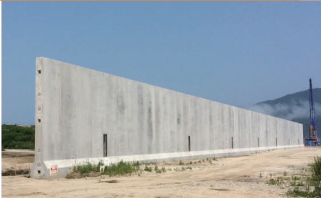
ハイブリッド防潮堤／ 204 〔受注先／(株)横河住金ブリッジ〕 岩手県沿岸広域振興局 岩手県宮古市 フォーチング金物 146.79t 連結金物 59.136t コンクリート打設 210㎡ 総延長 1.9km
