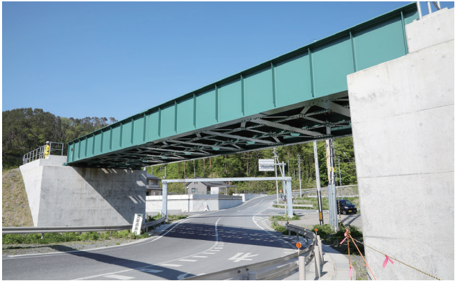
三陸鉄道 第三釜石街道跨道橋／153 東日本旅客鉄道(株) 岩手県釜石市 下路プレートガーダー単線 2主桁・枕木開床式 左内側歩道付 L 21.8m 40t
