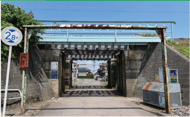
東北本線 南鍛冶町 Bv／167 [元請／ユニオン建設(株)] 東日本旅客鉄道(株) 岩手県花巻市 南鍛冶町Bv(上り下り) 上路プレートガーダー L 5.4m 鉄道桁 2橋
