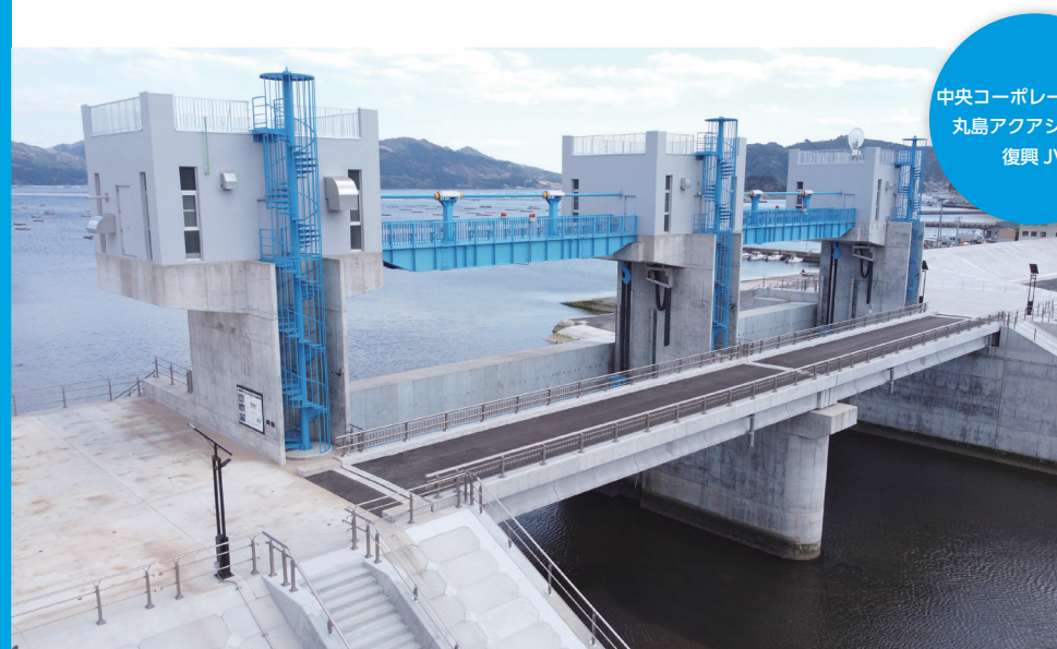
関口川水門／117 岩手県 岩手県山田町 シェル構造ローラーゲート W 24.3m × H 3.5m 2 門
