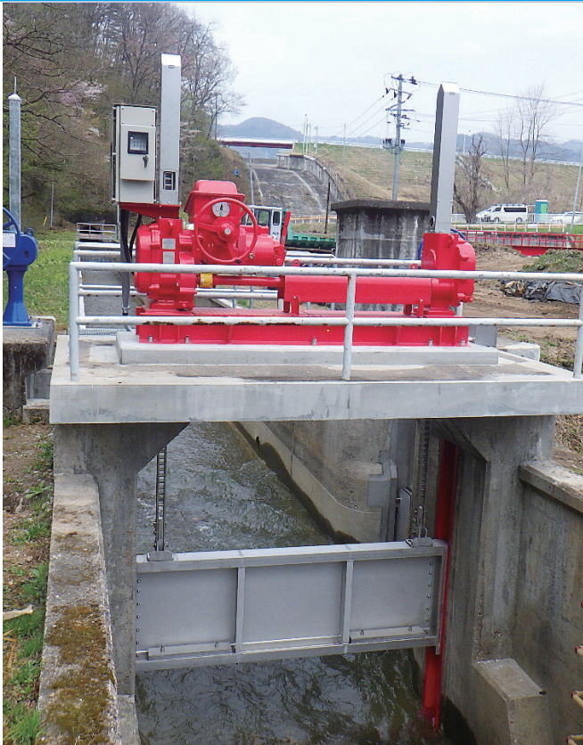
煙山ダム取水設備／144 東北農政局北上土地改良調査管理事務所 岩手県矢巾町 ステンレス製スライドゲート 取水ゲート：W 0.3m × H 1.5m 4門
