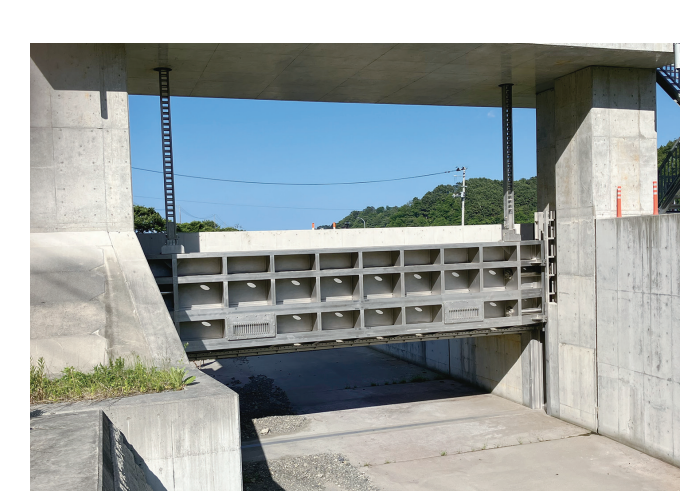
上平田川水門／128 [元請／(株)青紀土木] 釜石市 岩手県釜石市 ステンレス製ローラーゲート W 10.8m × H 2.2m
