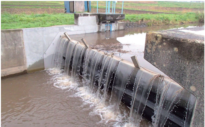
針前堰ゲート／145 宮城県王城寺原補償工事事務所 宮城県大衡村 起伏堰（ゴム袋体支示式）1門 W 8m × H 1.6m
