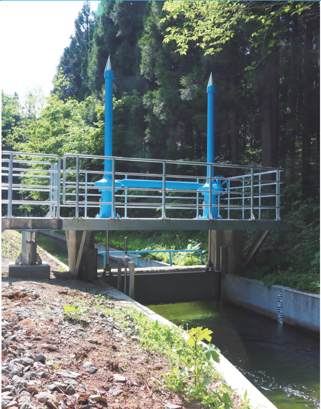
南部主幹線水路ゲート／138 東北農政局岩手山麓農業水利事業所 岩手県滝沢市 ステンレス製スライドゲート W 3m × H 0.7m 他
