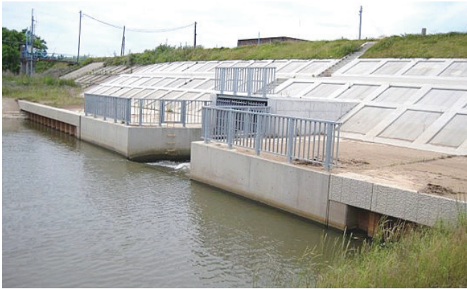
山吉田水門／140 [元請／(株)只野組] 宮城県東部土木事務所登米地域事務所 宮城県登米市 ステンレス製オーバーリンクゲート 1門 W 2.6m × H 1.4m
