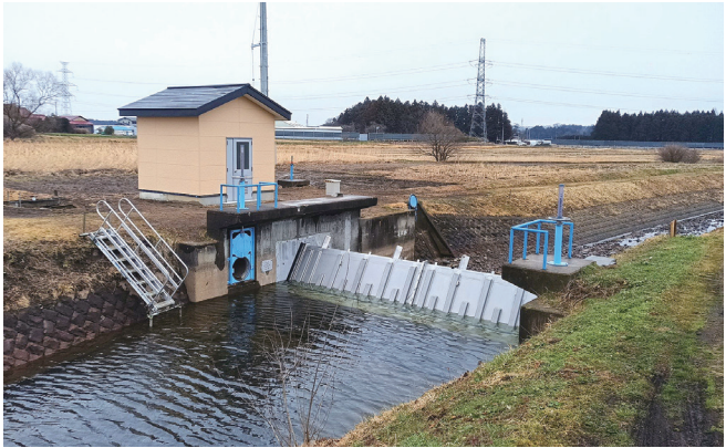
苗代堰ゲート／146 宮城県王城寺原補償工事事務所 宮城県大衡村 起伏堰（ゴム袋体支持式）W 8m × H 1.2m
