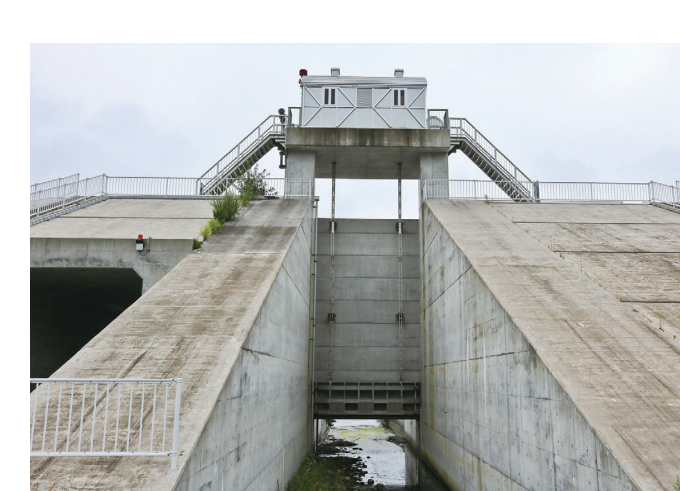
合定地区 2 号水門／111 岩手県沿岸広域振興局 岩手県大船渡市 プレートガーダ式ステンレス製ローラーゲート W 5.6m × H 1.8m 1 門
