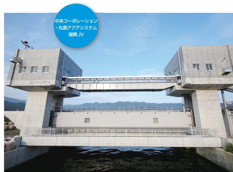
関口川水門／117 岩手県 岩手県山田町 シェル構造ローラーゲート W 24.3m × H 3.5m 2 門
