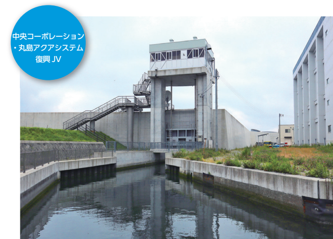
野々田水門 / 114 岩手県 岩手県大船渡市 アルミニウム合金製プレートガーダー構造ローラーゲート W 5m × H 3.2m 1 門
