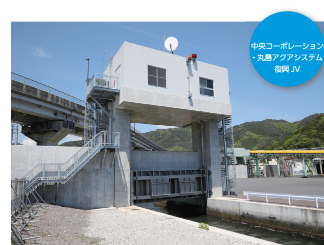
須賀水門／112 岩手県 岩手県釜石市 ステンレス製ローラーゲート W 8m × H 2.5m 1 門 他 3 門
