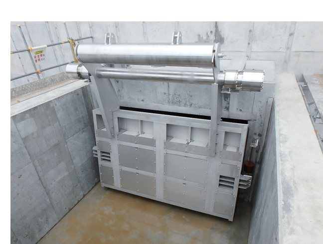
勝木田 3 号水門／131 陸前高田市 岩手県陸前高田市 ステンレス製オートゲート W 3.5m × H 2m
