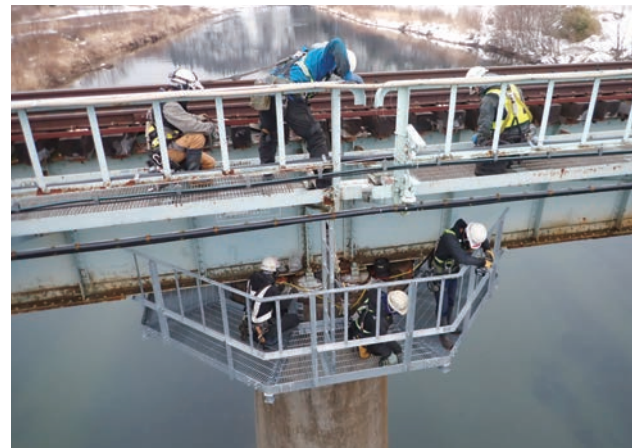
青い森鉄道 三戸・諏訪ノ平間(上)第3馬淵川B検査足場新設工事
