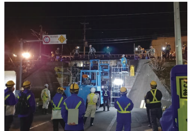
東北本線 村崎野・花巻間花巻Bv桁取替工事 夜間取替風景
