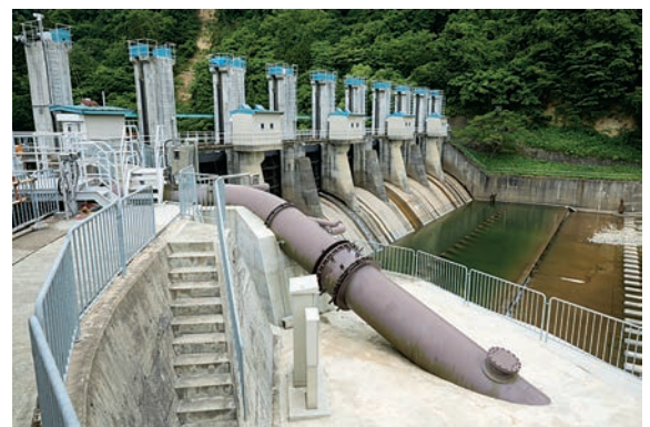
現在の岩手県企業局胆沢第二発電所
