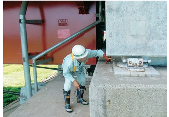
花巻市橋守制度に基づく橋梁の点検・清掃
