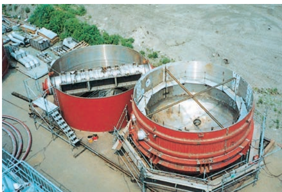
ステンレスタンクの据付現場
