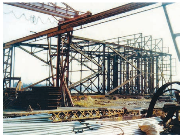
中国上海宝山製鉄所鉄骨組み立て
