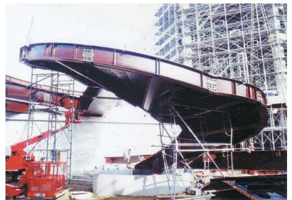
仙台泉ペDESTリアンデッキ(旧住友金属工業様向け)
