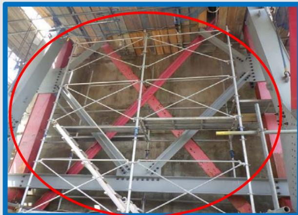
撤去して橋が変形しない様に補強します。
