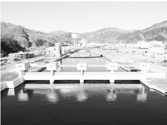
甲子川河口部に設置されたシェルゲート
