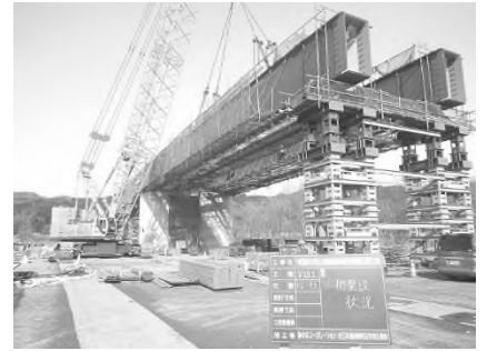
【ベント架設状況】
