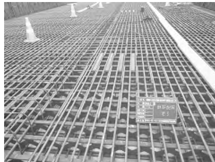
【床版鉄筋配筋状況】
