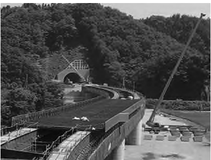
【グレーチング床版架設状況】
