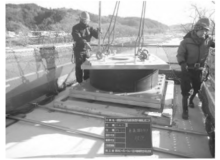
【支承設置状況】
