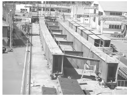
【工場仮組立状況】
