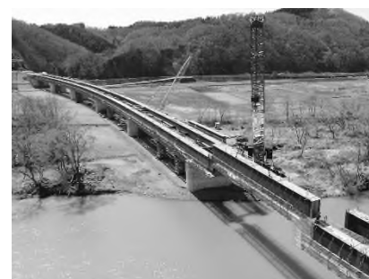
【主桁架設時に吊り足場を事前設置】
