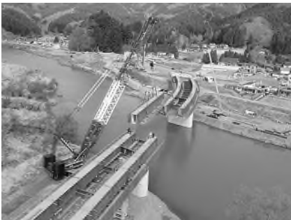
【大ブロック落とし込み架設状況】
