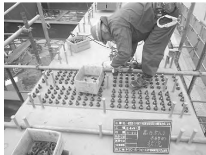
【現場継手状況】
