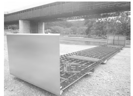
【グレーチング床版組立状況】
