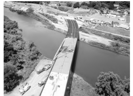
【床版打設状況】
