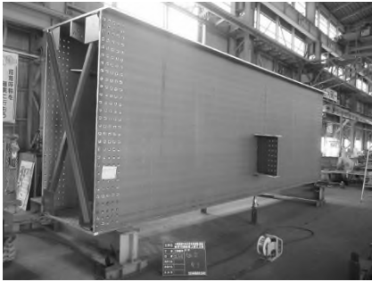
【工場製作状況】
